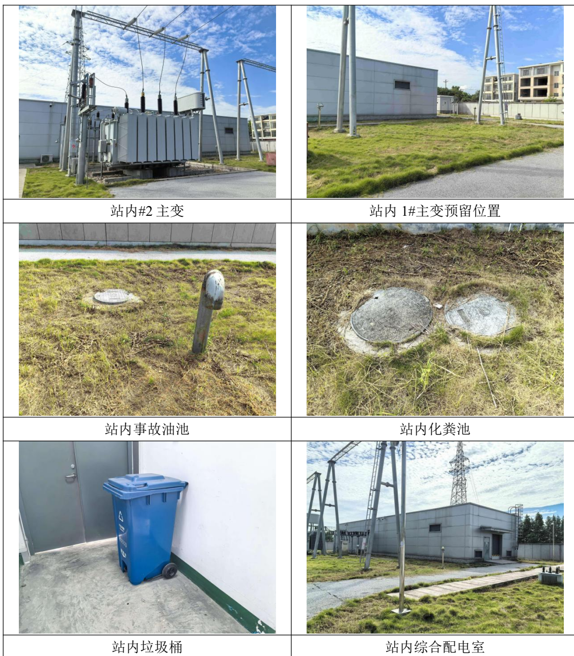
图 1 益丰 110kV 变电站站内环境现状
