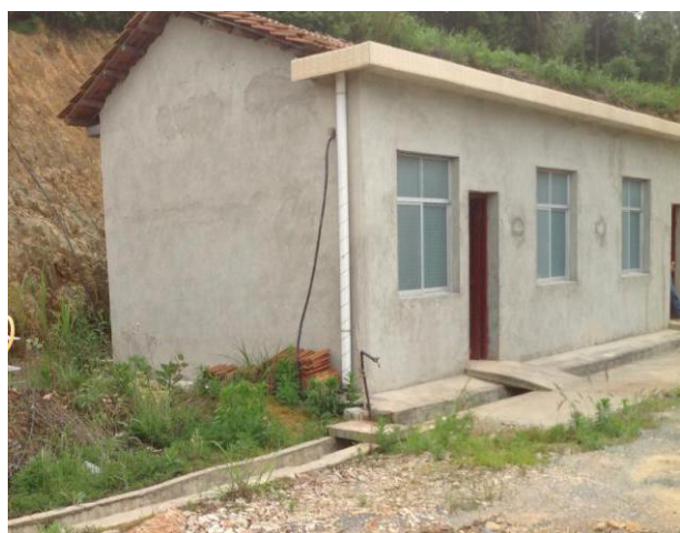
场区东面雨水沟
