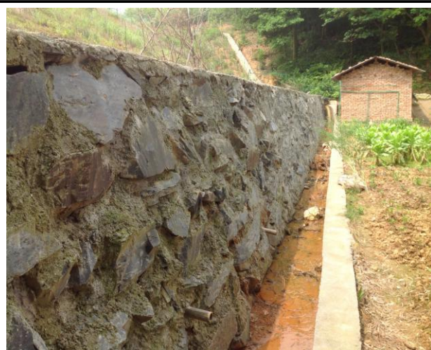
场区北面（垃圾坝下方）雨水沟
