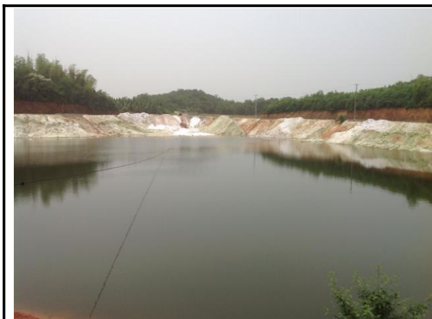
渗滤液收集池
