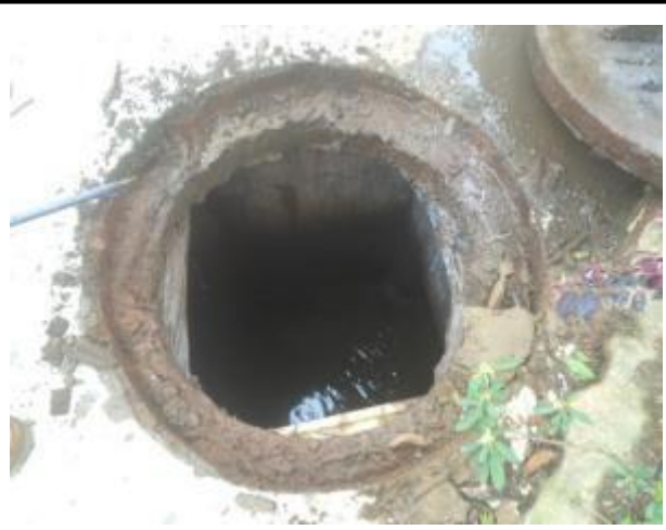
厂内地下井水监测取样点
